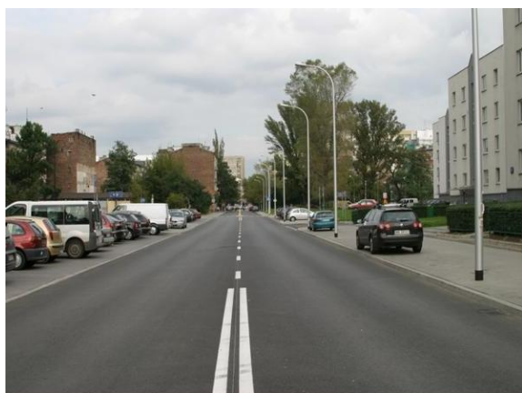
ul. Białostocka, zdj. Urząd Dzielnicy Praga-Północ m.st. Warszawy
