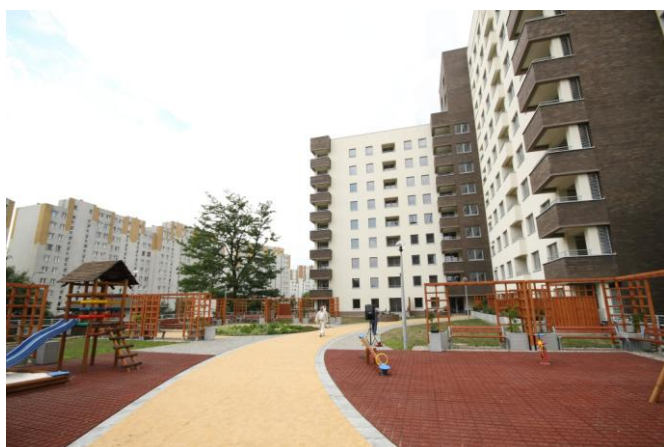
ul. Ossowskiego 9, budynek komunalny, zdj. Urząd Dzielnicy Targówek m.st. Warszawy
