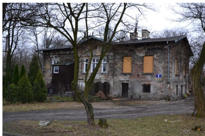
ul. Siarczana 6, zdj. Urząd Dzielnicy Targówek m.st. Warszawy
