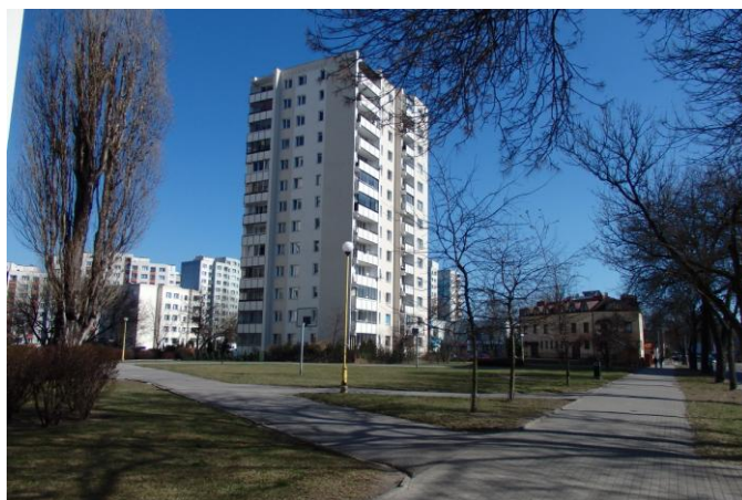
ul. Remiszewska, zdj. Urząd Dzielnicy Targówek m.st. Warszawy
